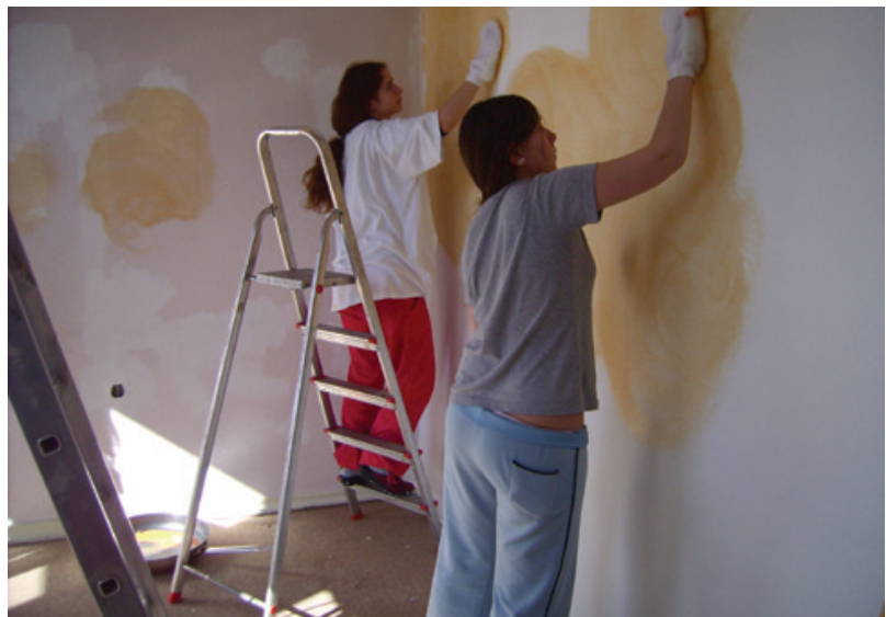
Jugendliche bei Renovierungsarbeiten während einer Abschlussreise im Schullandheim Ostseeheim Stein
