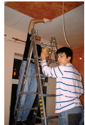
Feinarbeit an der Decke
